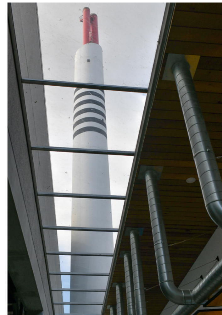
Cheminée de l'usine ARC EN CIEL 2034
