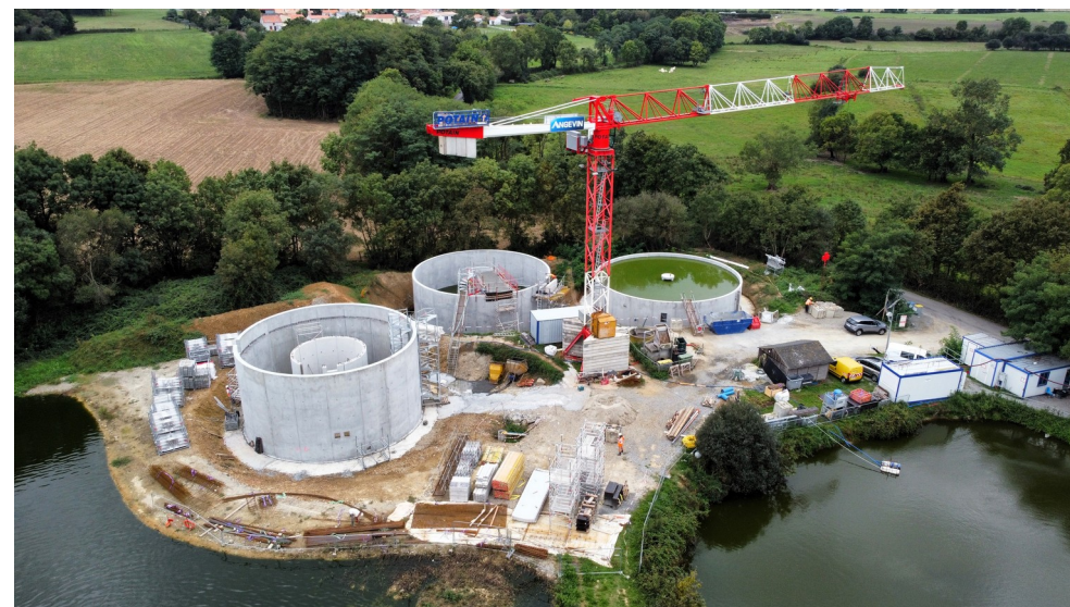
Construction station d'épuration de Brains 16
