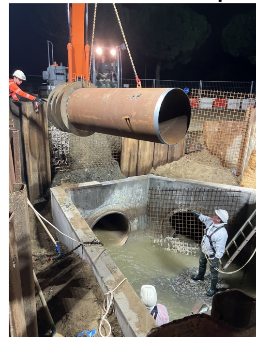
Renouvellement réseaux ZAC Pirmil les Isles
