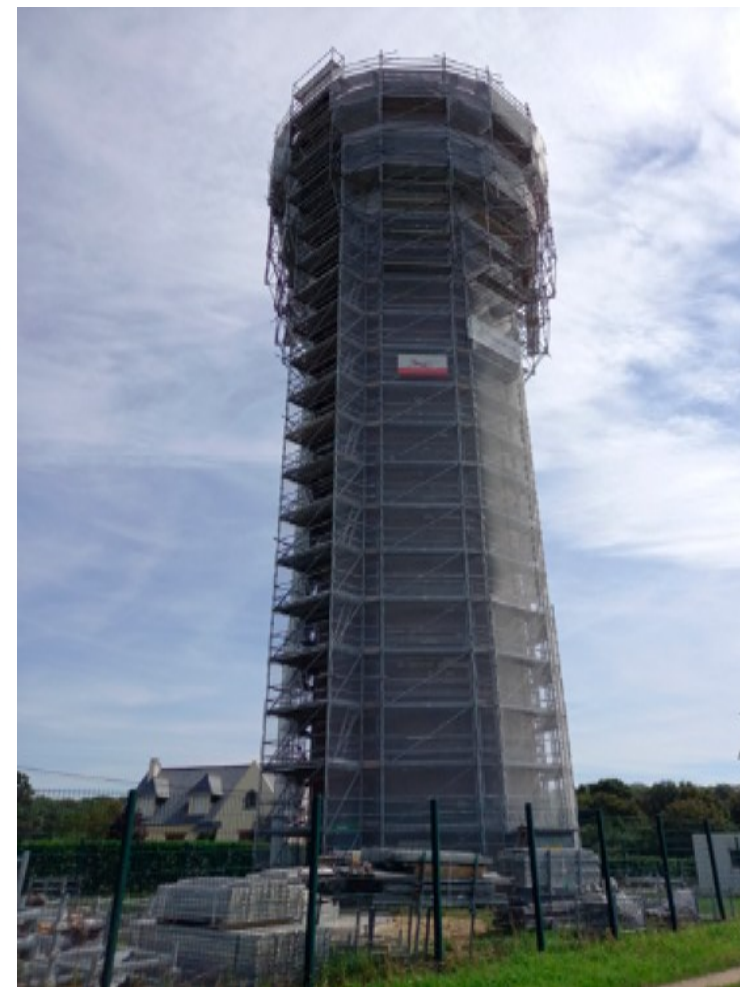
Travaux de réhabilitation du château d'eau de la Pilardière (Carquefou)
