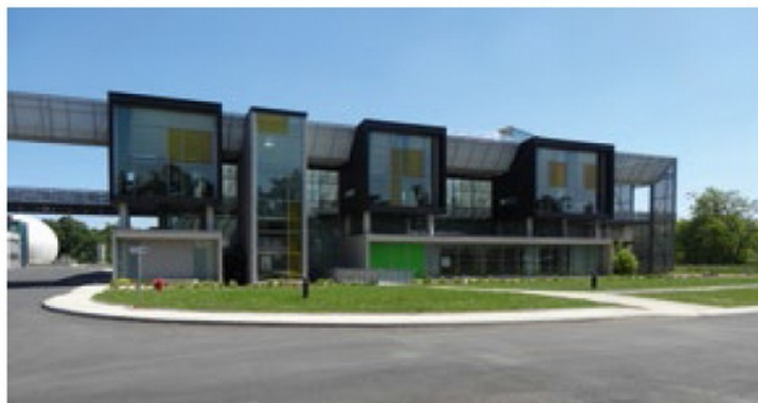
Station d'épuration Petite-Californie
