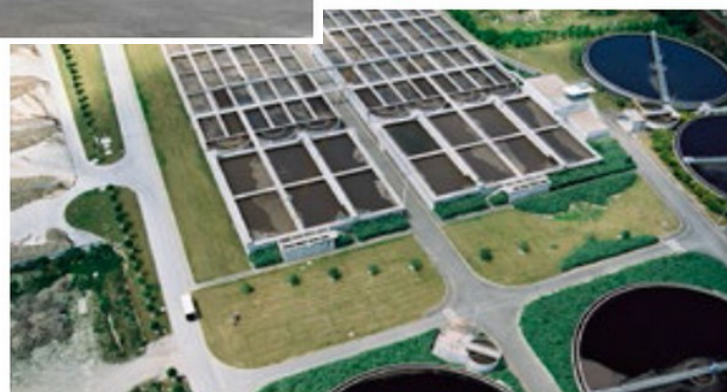
Station d'épuration de Tougas
