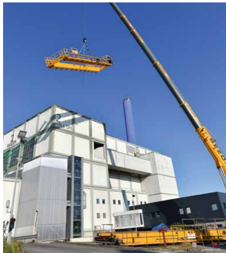
Opération de remplacement du pont roulant
