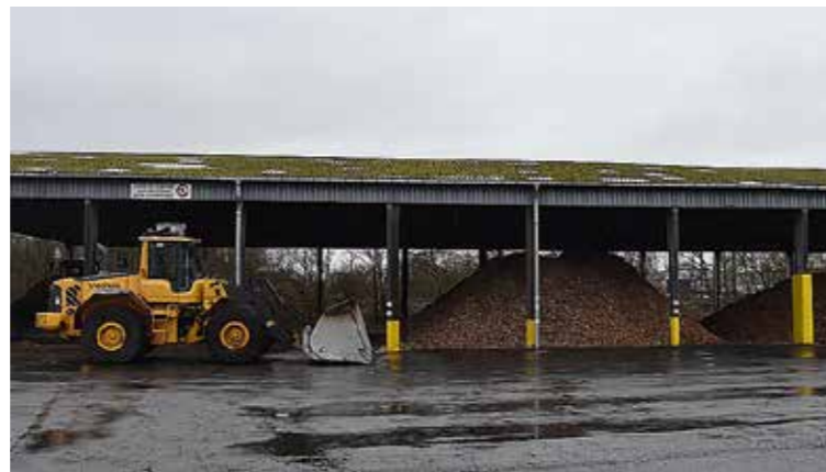
Plateforme de compostage des déchets verts - Saint-Herblain
