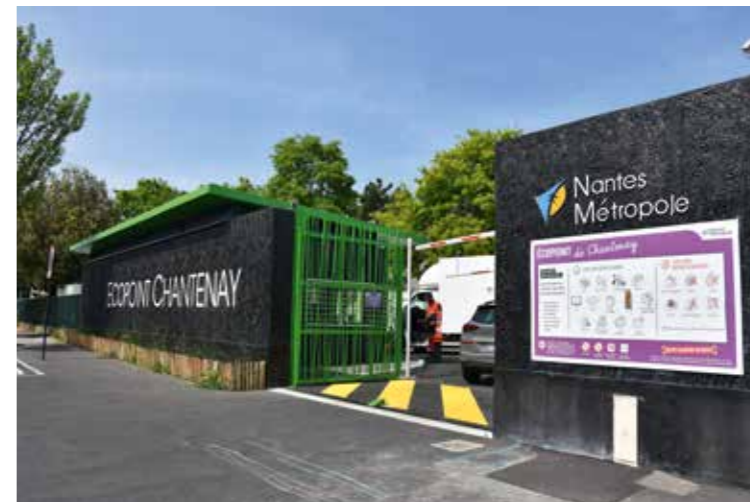
Ecopoint de Chantenay
